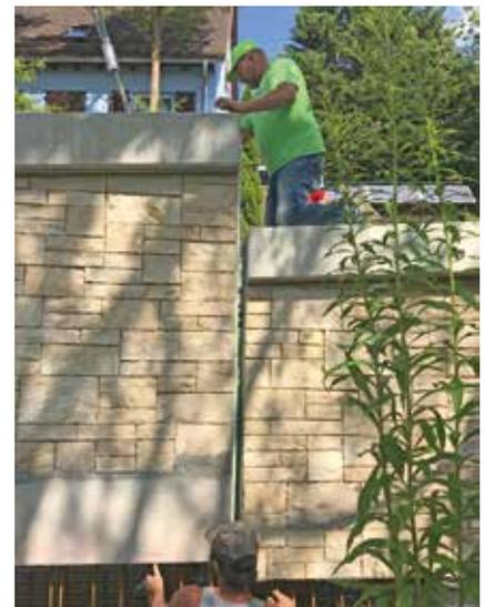
Wände werden auf die Betonsockel gehoben. Die Anschlussbewehrung der Wand greift in die Fundamentbewehrung
